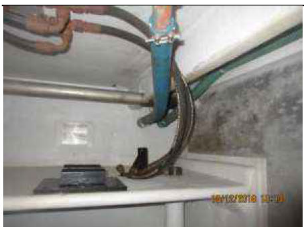
Drænslange med el-tracing er monteret i korrekt position december 2018.
